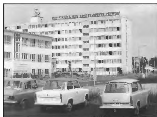
Neue Industriebetriebe sind errichtet worden, wie hier in Teltow bei Berlin zum Beispiel die VEB Geräte- und Reglerwerke, um im technischen Bereich die Produktion zu erhöhen.
